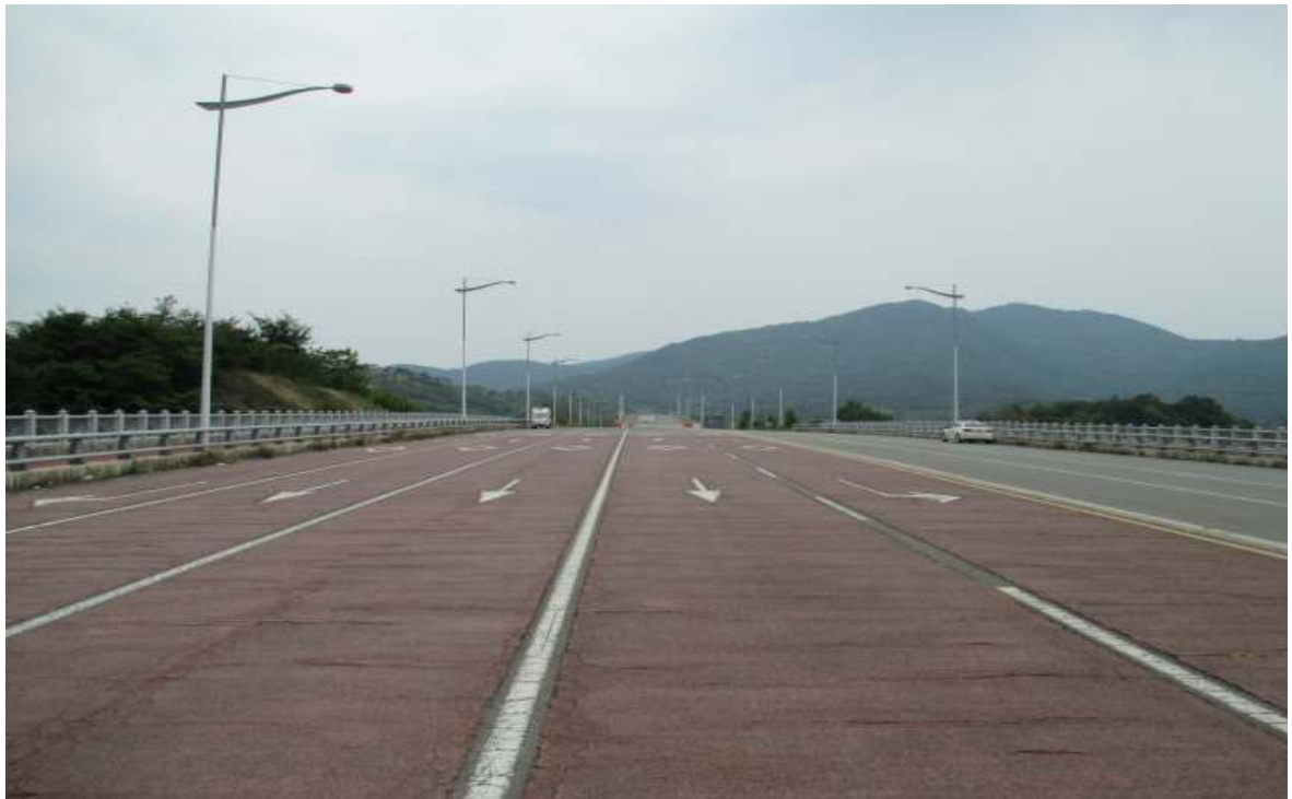
교량 상면 전경
