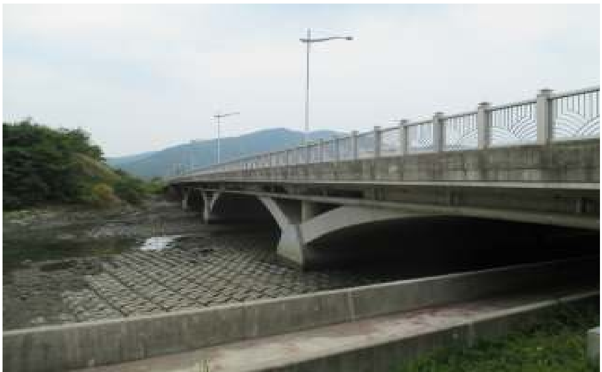
교량 측면 전경
